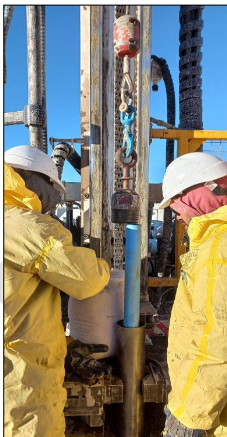
Figura 8-1: Instalación de cañerías en el sondeo BH14
