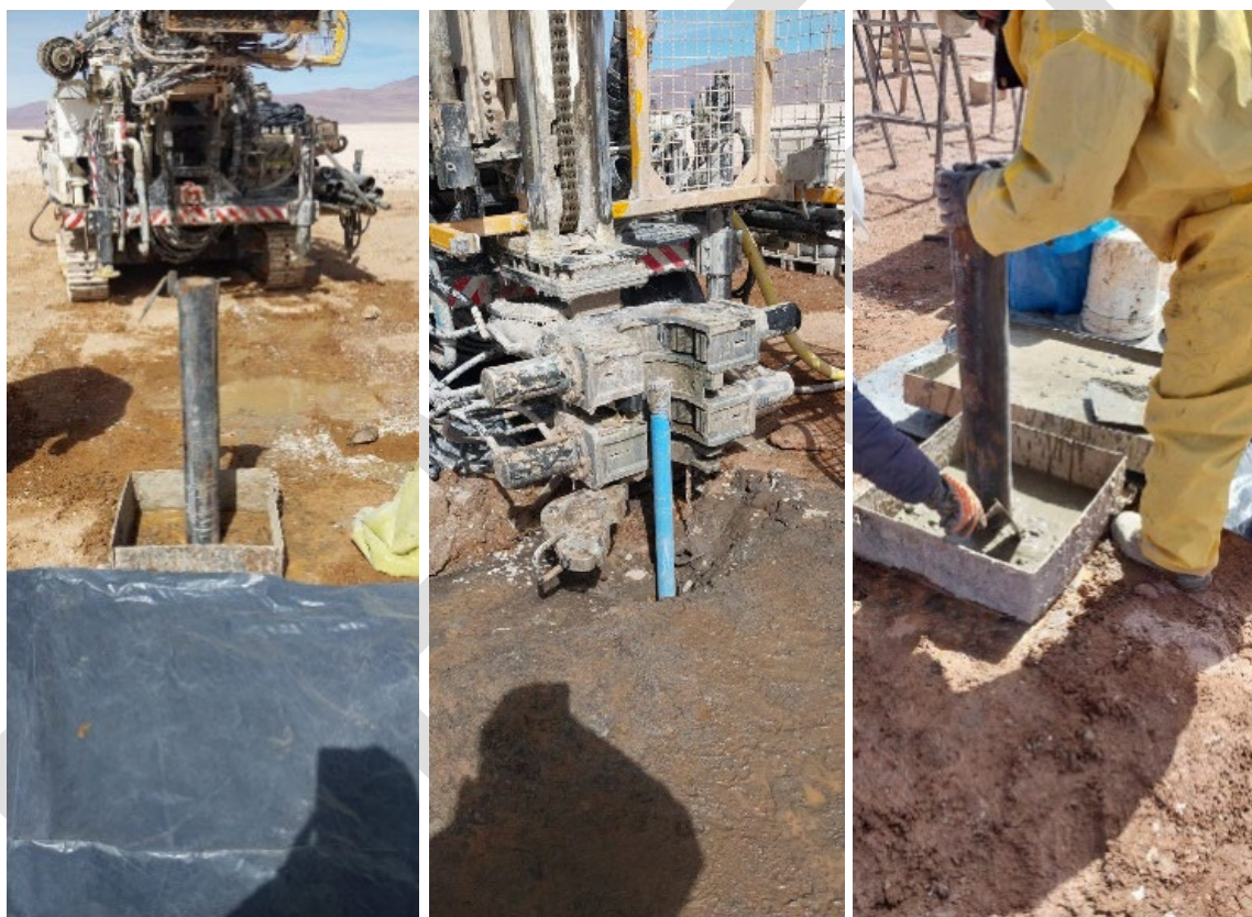
Figura 8-1: Instalación de cañerías en el sondeo BH09
