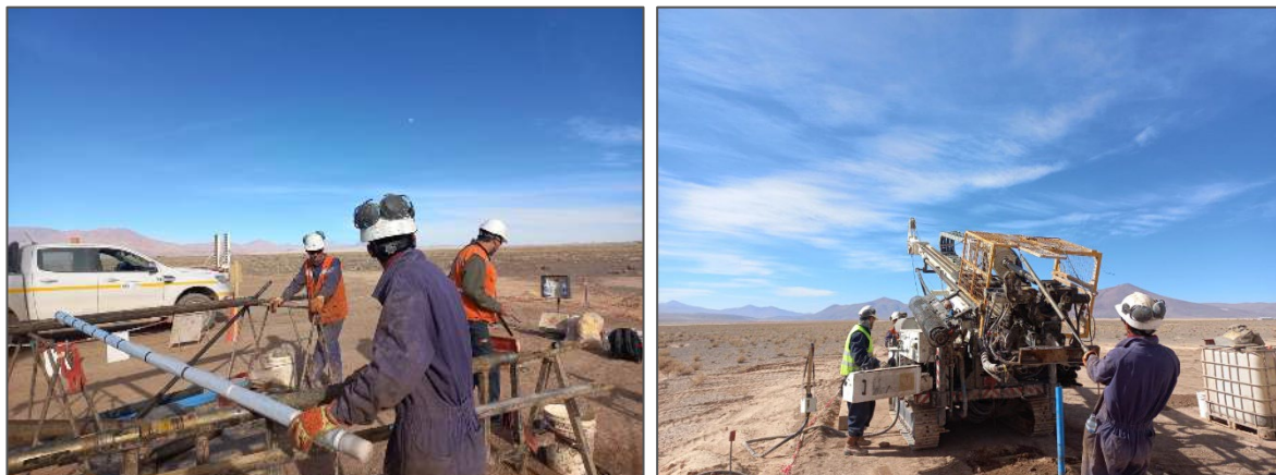
Figura 7-1: Construcción de piezómetro – instalación de tubo de PVC
