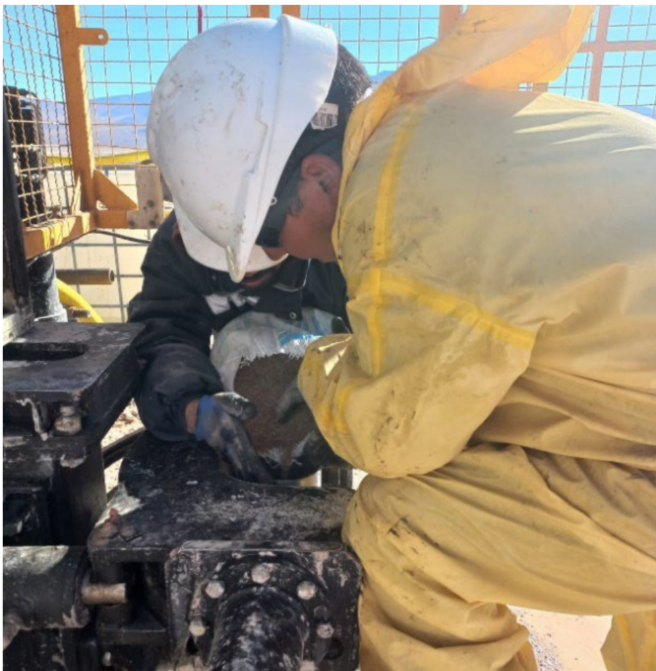
Figura 8-1: Imagen tomada durante la instalación del piezómetro BH19
