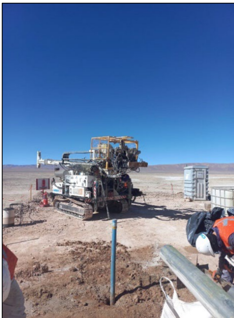
Figura 8-2: Instalación de cañerías en la perforación
