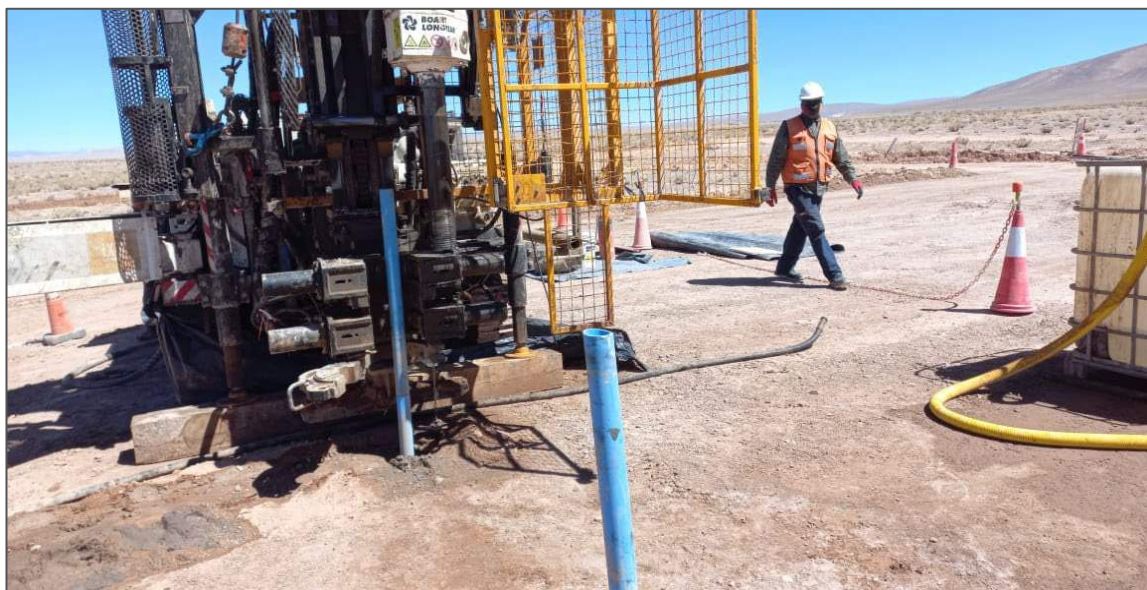
Figura 7-1: Construcción de piezómetros y la colocación de tuberías de PVC
