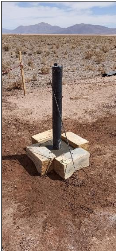
Figura 7-1: Instalación y construcción del brocal metálico y la base de hormigón
