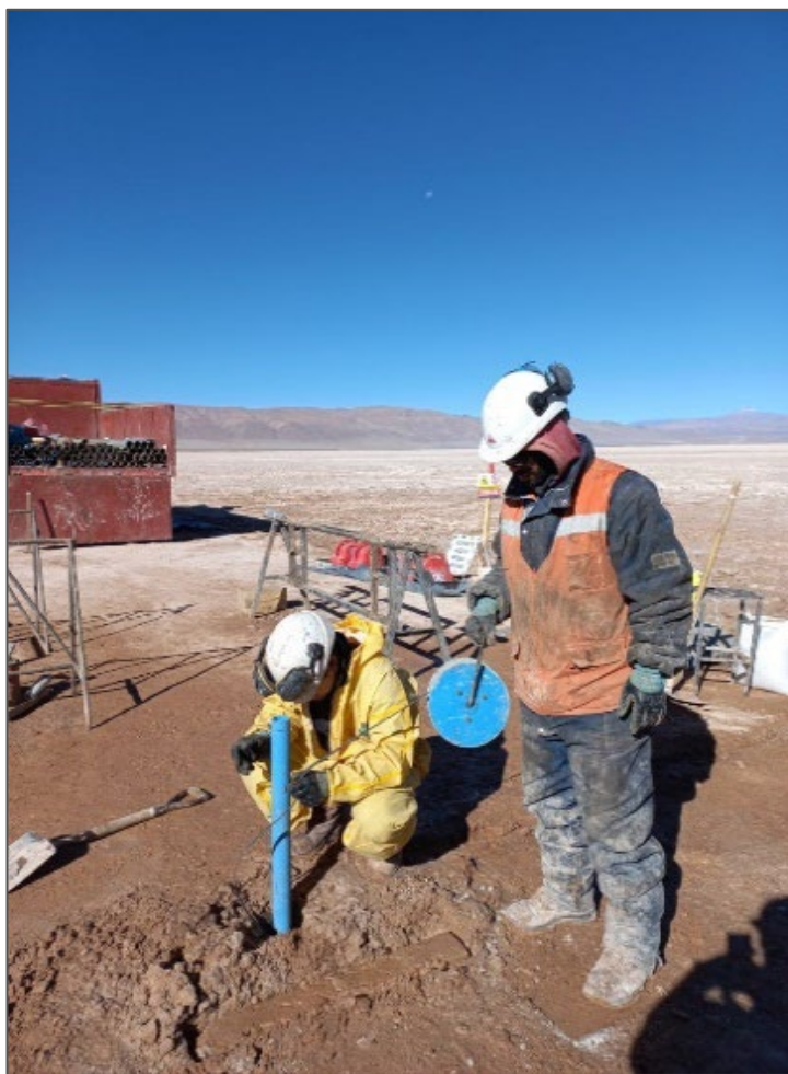
Figura 8-1: Instalación de cañerías durante la perforación BH-10
