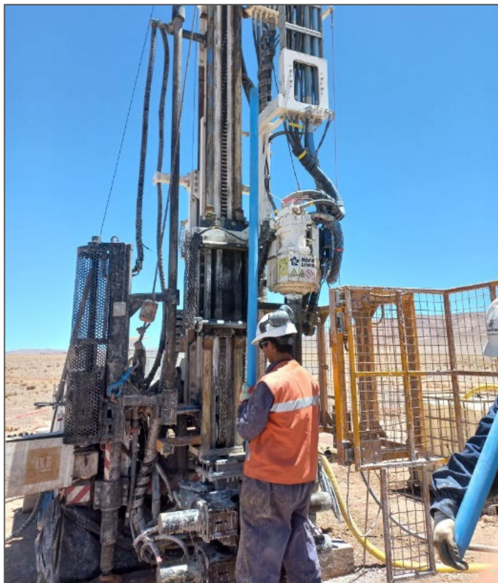
Figura 7-1: Construcción de piezómetro – instalación de tubo de PVC
